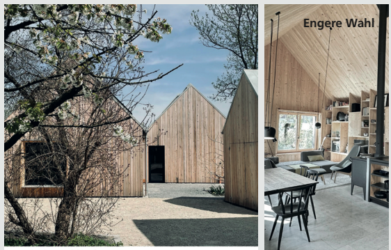
Neubau Einfamilienhaus Augustenfelder Str. 31 a, Dachau
